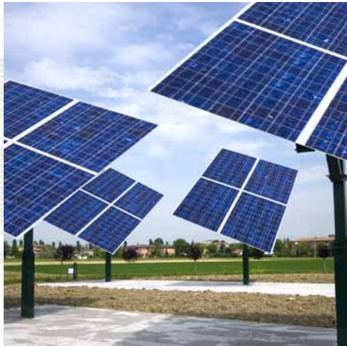
Bei String-Anlagen mit großen Abständen zwischen den Modulen entstehen hohe Verluste in den PV-Leitungen.
